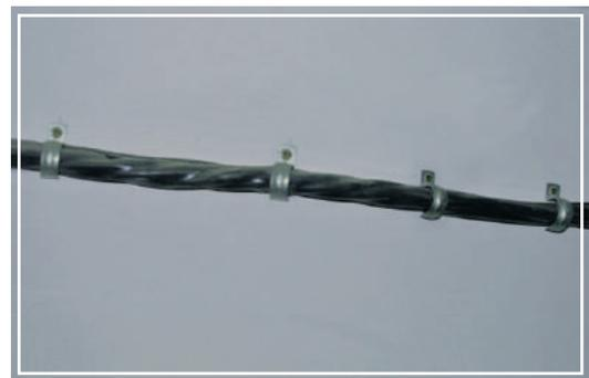
Пример крепления кабеля при помощи скобы монтажной металлической
