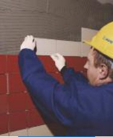
Укладка керамической плитки на стены сверху вниз
