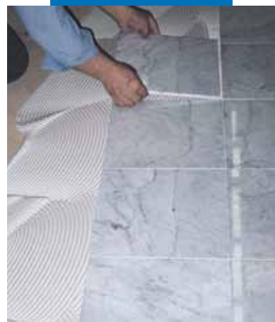
Укладка мрамора Saiga на деревянное основание, используя белый Keralastic
