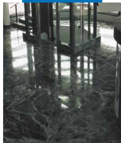
Полы, облицованные зеленым мрамором "Alpi" в холле здания Rolex (Бленн - Швейцария)
