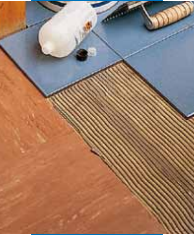
Укладка на старое ПВХ покрытие
