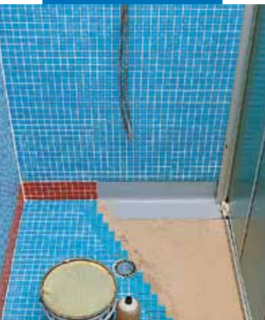
Гидроизоляция и укладка облицовки в душевой кабинке
