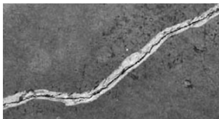
Рисунок 3. V-образная канавка вдоль трещины
