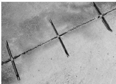
Рисунок 4. Установка стяжек в каналы, открытые в трещинах
