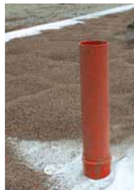
Наземная часть инспекционной трубы диаметром 200мм
