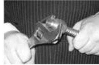
Рис 3 Затягиваем накидную гайку
