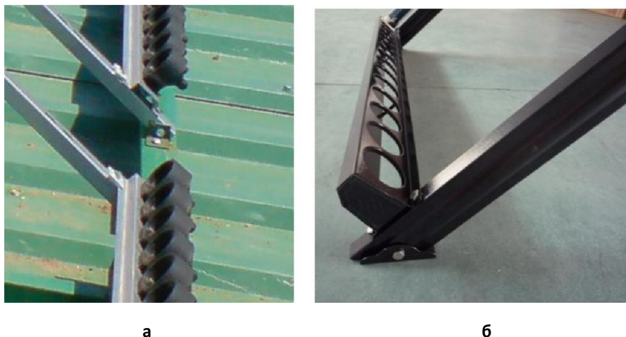
Рис. 2.6 а – пример фиксации крепежного пятака к направляющим полосьям; б – нижняя опора сезонных систем
