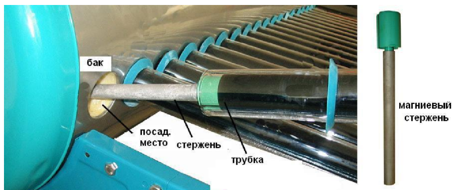
Рис. 4 Способ установки магниевого стержня
