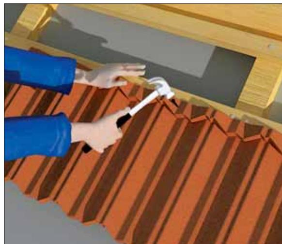
Черепица укладывается посредством подъема обеих кровельных листов в ряду и запуская следующий ряд под уже установленную черепицу. Начиная укладку от уже уложенного ряда, укладывайте два ряда одновременно от края до края. Кровельщик, укладывающий черепицу, должен быть на два ряда впереди от того, кто забивает гвозди.
