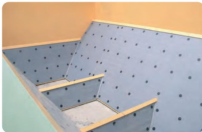
Облицовка бункера методом сварных шпилек с резьбой: хорошо заметно расположение крепежных точек.
