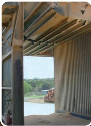
Бункер (вид снизу): при перевалке крупнозернистых сыпучих материалов, которые значительно усиливают износ, даже неполная облицовка плитами Matrox значительно повышает срок эксплуатации бункера.
