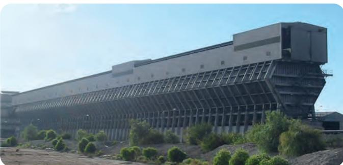
Угольный бункер электростанции облицован листами Matrox EX 60: эксплуатационная надежность и непрерывная подача угольного топлива играют большую роль в электроэнергетике.
