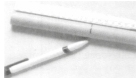
рис. 30: Измерим и обозначим требуемую длину трубы (нужно не забыть причесть длину части трубы, которая всовывается во время сварки в фасонину). На трубе рекомендуется обозначить длину всовывания конца трубы в фасонину.
