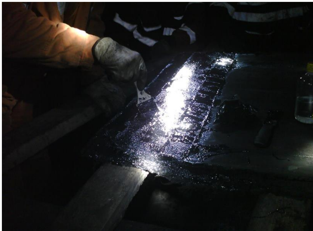
Рис. 6. Нанесение компаунда 3М серии Scotchcast 2131 на тканевые прокладки
