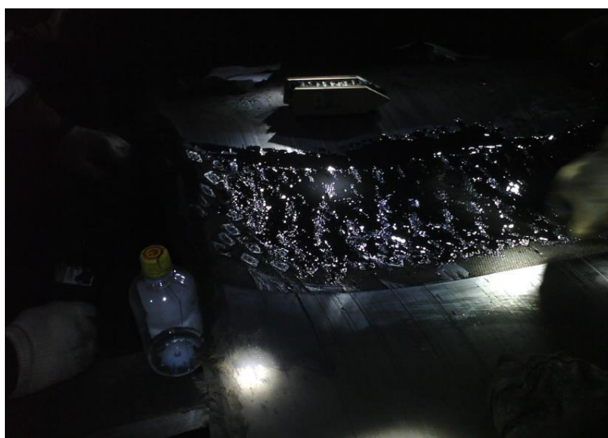
Рис. 10. Процесс нанесения компаунда 3M Scotchcast 2131 поверх стыка
