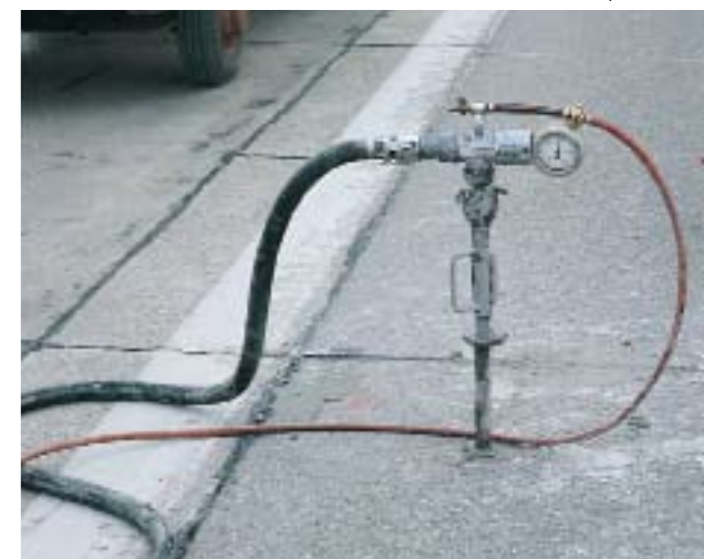
Заполнение цементной суспензией полости под полотном проезжей части.
