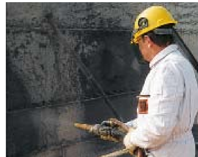
Более грубый торкрет-бетон (здесь 8 мм) можно подавать только поршневым насосом Р 13.
