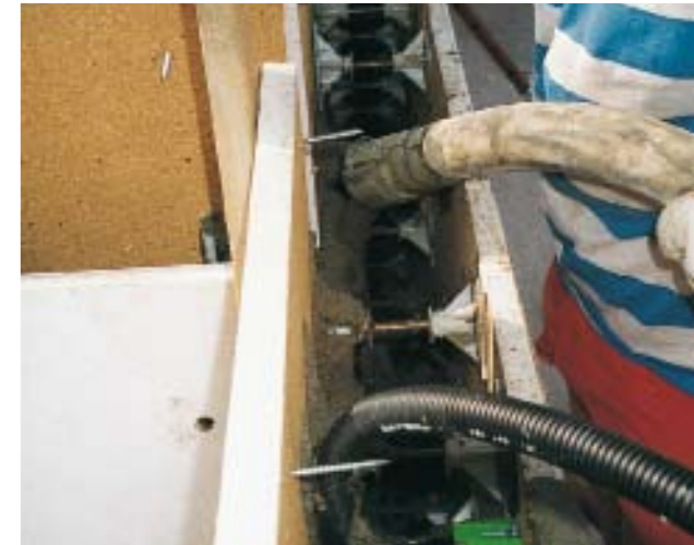
Наряду со стандартными задачами, такими как нанесение грунтовки и штукатурки, Р 13 также отлично подходит для использования в случаях, когда нужно подавать большие объемы раствора, как, например, при заполнении опалубки.
