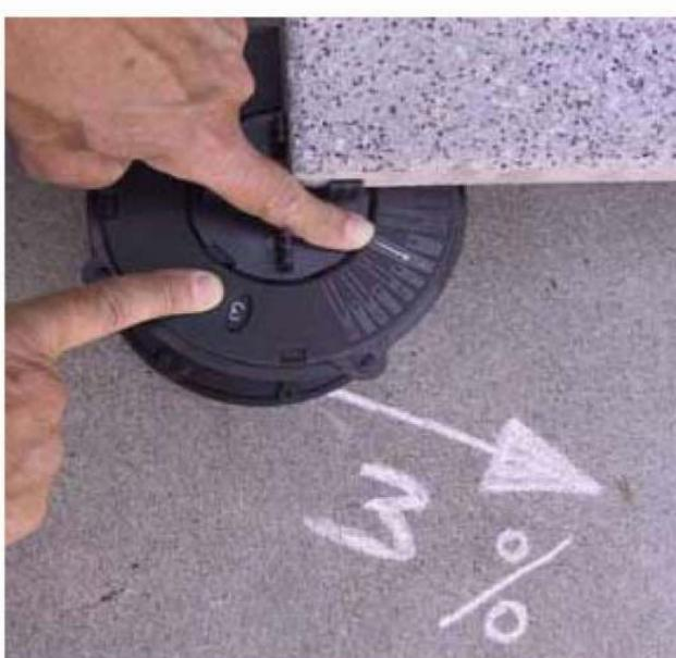
Стрелка с номером 3, показывает направление к вершине уклона. Корректор угла наклона должен быть установлен по направлению к стрелке, обозначенной на поверхности кровли (который указывался в шаге 2). Вершина опоры должна иметь полную горизонтальность во всех направлениях. После укладки на опору плитки осуществляется регулировка ее необходимой высоты.
