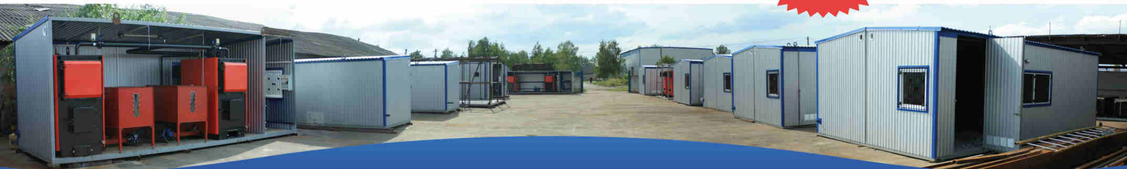
МОНТАЖ котельной без фундамента
