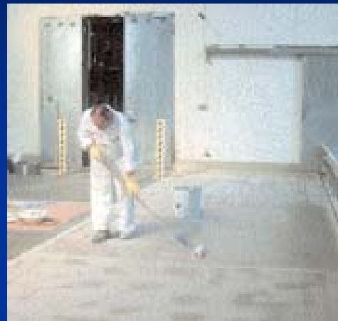
INDUFLOOR-IB 1225 Грунтовка-GWS, Защита водной среды (нанесение валиком)
