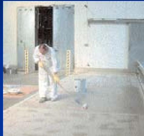
INDUFLOOR-IB 1225 Грунтовка-GWS, Защита водной среды (нанесение валиком)
