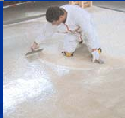
INDUFLOOR-IB 1230 Быстросхватывающаяся грунтовка, (нанесение методом процарапывания)
