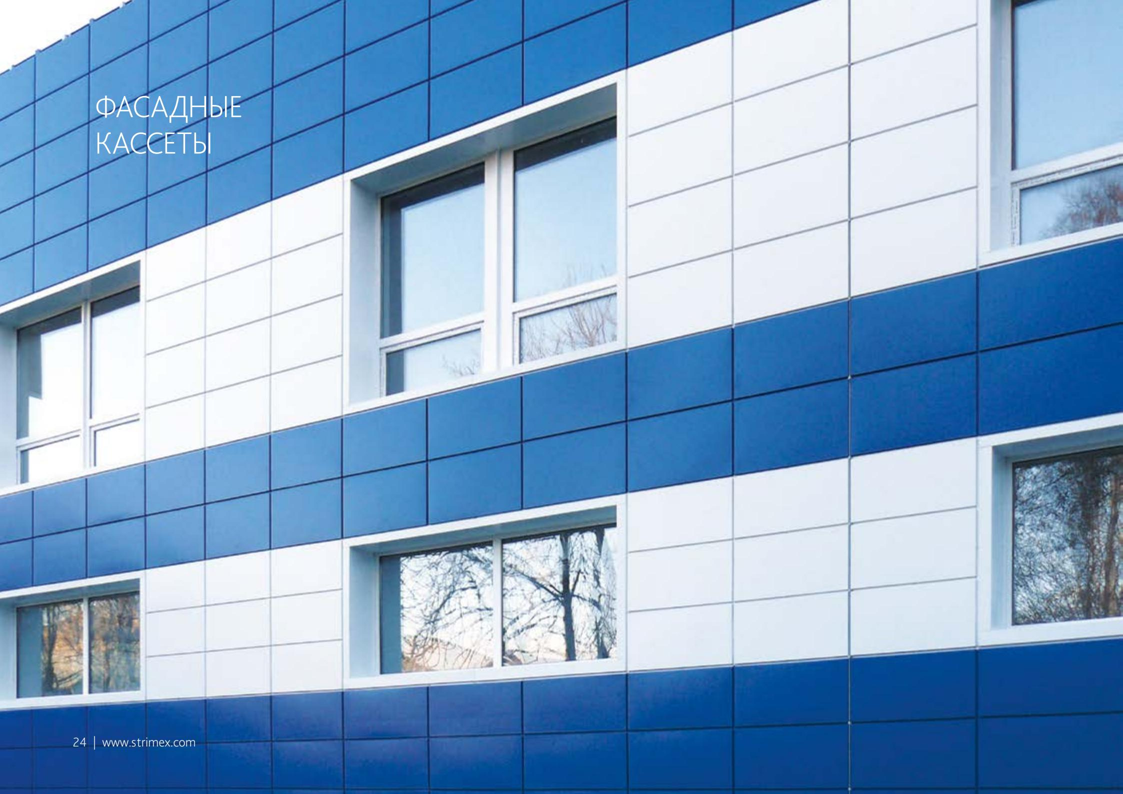
Современные фасадные кассеты производятся из оцинкованной листовой стали, толщиной 0,4–1,5 мм и могут быть как штучными (в виде квадрата, прямоугольника или другой произвольной формы), так и погонажными (в виде панелей от 2-х до 3-х метров в длину). Зачастую стальные листы покрываются полимерами: полиэстером, порошковым покрытием.
