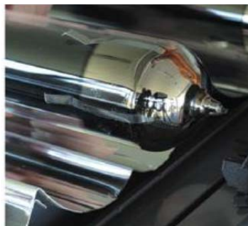
газопоглотитель в порядке, трубка исправная
