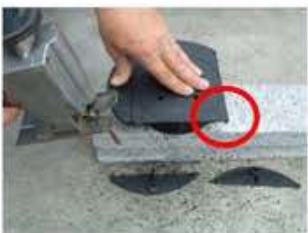
Во избежание повреждения изоляционного слоя на стене также рекомендуется обрезать этот угол
