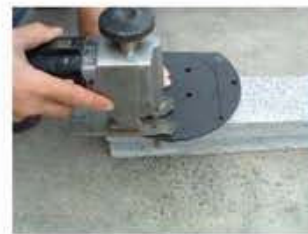
Во избежание повреждения изоляционного слоя на стене также рекомендуется обрезать этот угол
