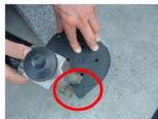
Во избежание повреждения изоляционного слоя на стене также рекомендуется обрезать этот угол
