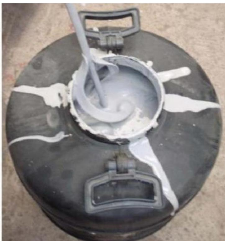
4. Следует перемешивать материал до тех пор, пока не получится однородная «сметанообразная» субстанция без комочков. При загустевании материала, его разрешается разбавить водой до нужной консистенции (но не больше чем 5% к общему объему массы материала) и тщательно размешать. Полученный состав необходимо периодически помешивать. После достижения данного результата материал готов к использованию.
