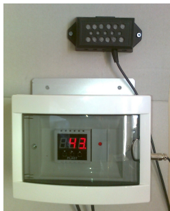
Рис.3 Модуль влажности канального увлажнителя Вдох-Нова 12000/15000 и его блок питания.
