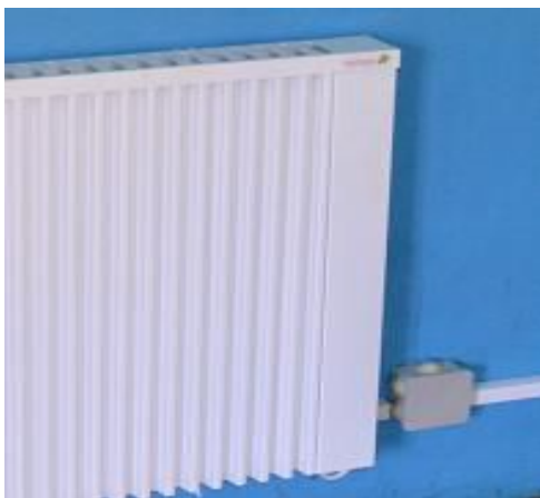
Підключення через розподільчу коробку
