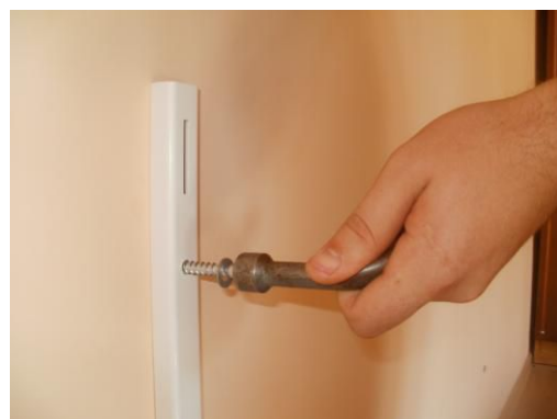
Процес кріплення планки до стіни
