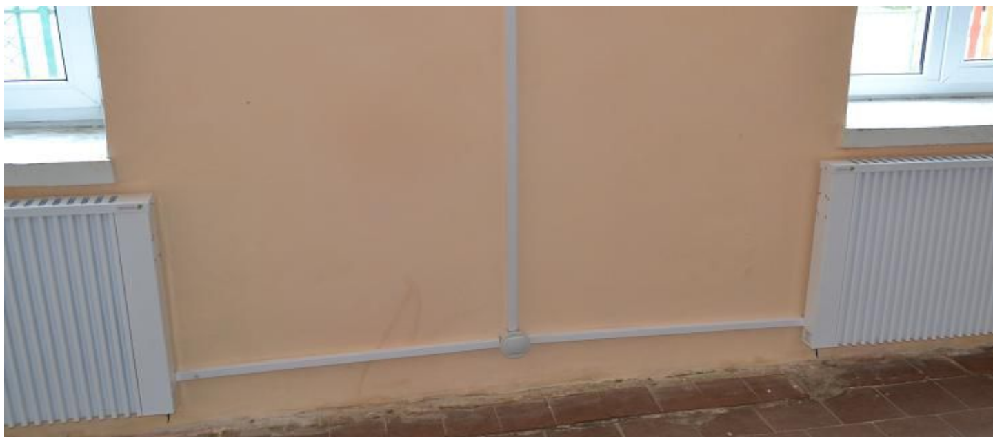
Підключення через розподільчу коробку
