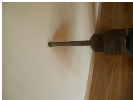
Процес кріплення планки до стіни
