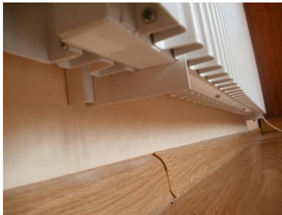
Правильне положення обігрівача на нижніх кронштейнах
