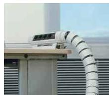
В круглом гибком коробе провода подводятся от напольного канала или плоского короба или непосредственно из-под пола к рабочему месту
