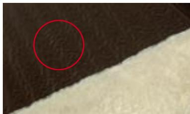
Панель изготовлена из оцинкованной листовой стали с высококачественным полимерным покрытием. Лицевая поверхность панели имеет рисунок (тиснение в виде микроволн), скрывающий на полотне ворот мелкие царапины, которые могут появиться в процессе эксплуатации.
