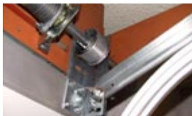
Каждая торсионная пружина оснащена устройством, защищающим от обрыва пружин. Полотно ворот фиксируется в положении на момент обрыва.
