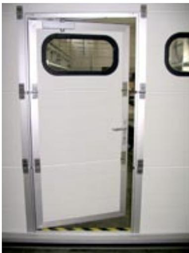
В калитке «Алютех» используется более 10 усиленных алюминиевых профилей обрамления калитки. Современный линейный доводчик позволяет использовать калитку во всех типах монтажа.
