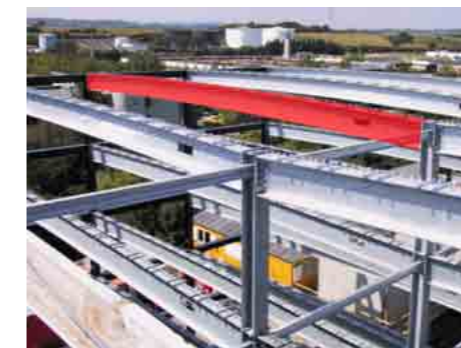
271 Träger vorspannen im Stahlbau Beam cambering
