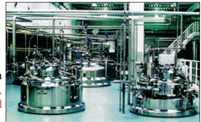
Завод, Польша Industrial Plants, Poland
