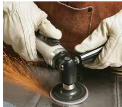
Рис. 93. Зачистка сварного шва
