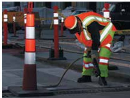
Рис. 85. Часто единственной возможностью обозначить присутствие человека является использование специальной сигнальной одежды повышенной видимости со световозвращающими элементами.
