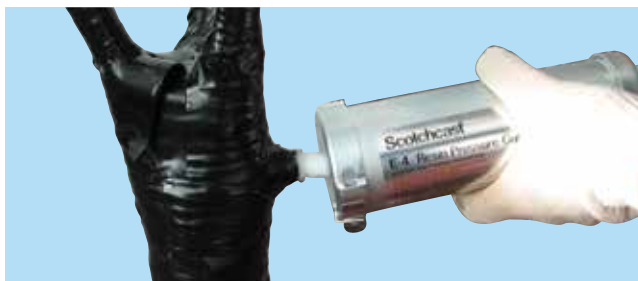
Рис. 35 б. Применение ремонтного комплекта 92-0Т РК1 для ремонта текущей концевой заделки
