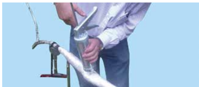
Рис. 35 а. Применение ремонтного комплекта 92-0Т РК1 для ремонта текущей оболочки кабеля или текущего кожуха соединительной муфты типа СЭФ, СС либо термоусаживаемой муфты
