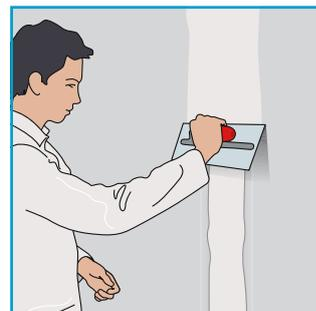
Нанесите дополнительный более тонкий слой шпаклевки и удалите ее излишки. Выведите нанесенную шпаклевку за пределы стыка – приблизительно на 100-200 мм.
