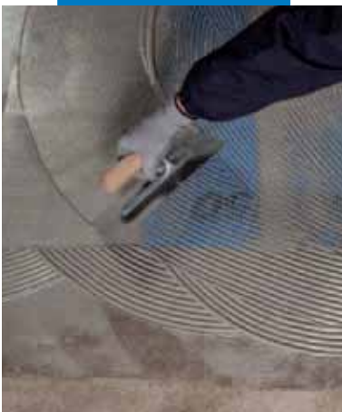
Укладка Mapenet 150 поверх первого свежего слоя Mapelastic Turbo
