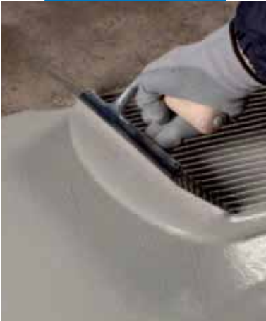
Нанесение первого слоя Mapelastic Turbo
