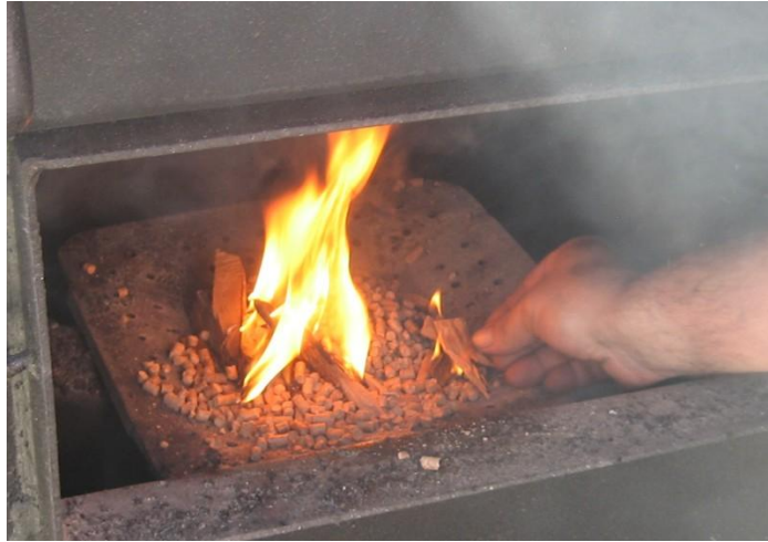
Малюнок 7 - Ручне розпалювання палива в котлах версії RK3G/S
