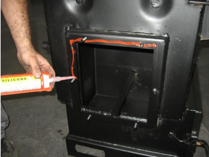
Малюнок 15 - Нанесення жаростійкого силікону перед встановленням прокладки.
