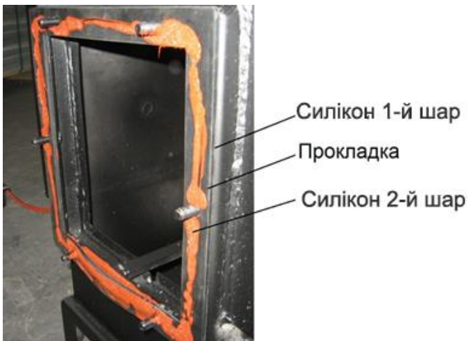
Малюнок 16 - Встановлення прокладки на силікон і нанесення другого шару.
