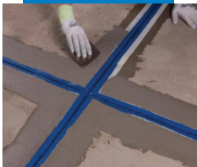
Герметизация компенсационных швов на террасе
