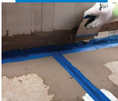
Гидроизоляция углов на стыке стена/пол
