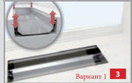
**3. Вариант 2.** Установить прибор в канал, выровнять по уровню горизонта с помощью регулировочных болтов.
