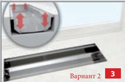
**4.** Закрепить конвектор в ложе. Изолировать и уплотнить пространство между прибором и каналом изоляционным уплотнительным материалом.
