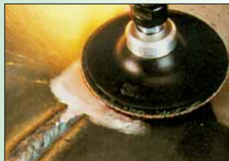
удаление сварного шва
