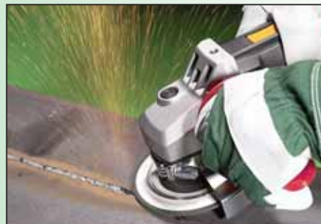
удаление сварного шва
