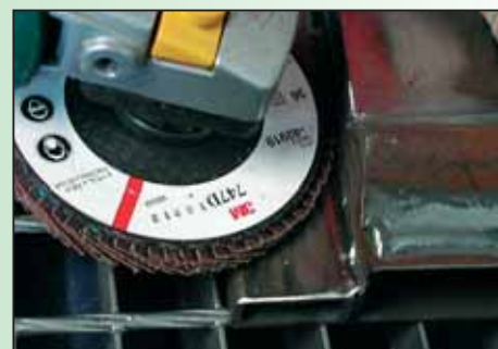
зачистка сварного шва
