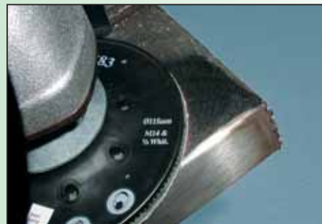
шлифование сварного шва
