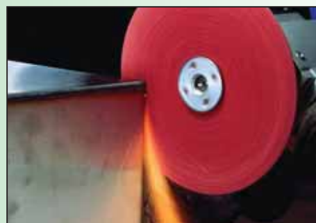
зачистка сварного шва
