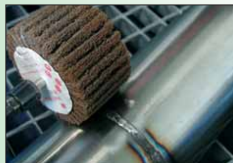
защитка сварного шва
