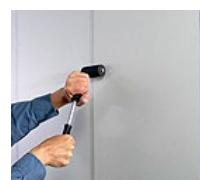
5. После позиционирования панели удалите лайнер вытягиванием его из промежутка между лентой и профилем. Прижмите ленту прикаточным валиком. Сила прижима должна быть не менее 2 кг на см<sup>2</sup>.
