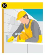
Внутренние стены и перегородки можно выполнять с перевязкой с внешней стеной или встык, используя для связи пластинчатые с антикоррозионным покрытием.
