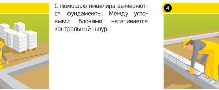
Кладка начинается с наивысшего по отметкам угла здания. Первый ряд укладывается на цементный раствор толщиной не менее 20 мм для компенсации неровностей фундамента. С целью предотвращения увлажнения стен, кладка производится на гидроизолирующий слой рубероида или другого аналогичного материала.
