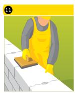
После кладки очередного ряда блоков, с помощью терки поверхность выравнивается, а затем очищается мягкой щеткой для улучшения адгезии с клеем.
