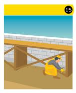
Для перекрытия оконных и дверных проемов необходимо устраивать армированные перемычки, которые можно изготовить с помощью UDK U-Block®. Длина опирания перемычки должна быть не менее 200 мм с каждой стороны.
