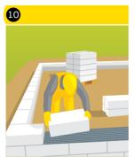
К кладке второго ряда можно приступать после схватывания цементно-песчаного раствора первого ряда. Обычно, на следующий день. Кладка начинается с углов здания, последующие ряды кладутся с перевязкой блоков, т.е. смещением. Клей также наносится на торцы блоков.
