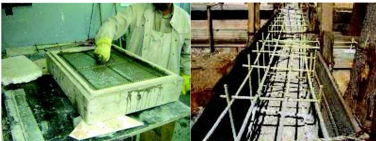
Использование для изготовления гибких связей в слоистой кладке кирпичных зданий
