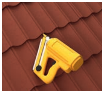
РИС.12.2 Крепление пневмопистолетом
