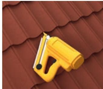
РИС.12.2 Крепление пневмопистолетом
