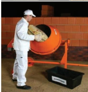
Для кладки наружных стен используют специальный теплоизолирующий либо обычный кладочный раствор. Подвижность раствора должна быть 7 - 8 см. Крупность заполнителя не более 3 мм.
