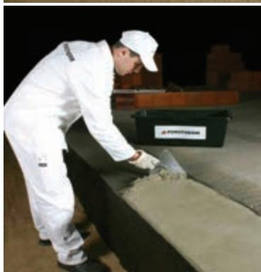
Во время кладки при применении теплоизолирующего раствора температура окружающего воздуха должна быть не ниже, чем +5°C. Перед укладкой блоки **Porotherm** необходимо смачивать водой, чтобы они не поглощали интенсивно воду из раствора.
