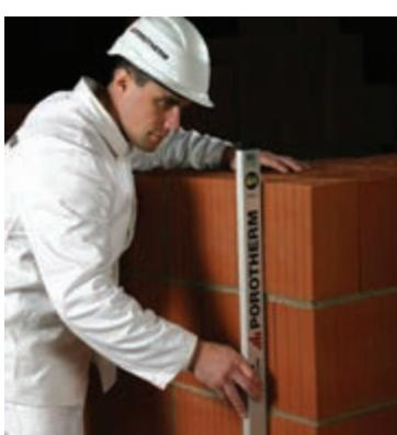
Контроль вертикальности стен надо выполнять на углах при помощи отвеса / строительного уровня после выполнения каждого ряда блоков. Контроль горизонтальности кладки между углами в плоскости и из плоскости стены выполняется с помощью шнура каменщика. Контроль высоты кладки облегчает использование порядковки – вертикальной рейки с отметками высоты ряда кладки.
