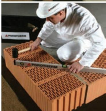
Кладку наружных стен начинают от углов. Углы выполняются из целых блоков, с применением половинок и угловых блоков, или только половинок.
