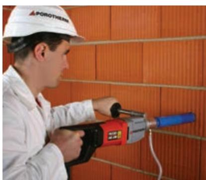
Сверлить дрестью можно обычным или коронарным сверлом, но безударным способом. Стены обязательно оштукатуривают снаружи и внутри. Для штукатурки используют известковые и цементно-известковые растворы. Наружную поверхность покрывают декоративной штукатуркой или окрашивают фасадными красками.
