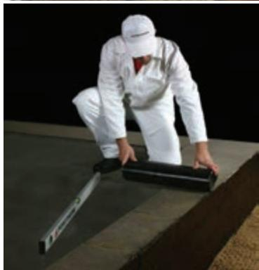
Следует помнить, что неровное основание не позволит качественно и быстро выполнить кладку. Для предотвращения подтягивания капиллярной влаги перед началом кладочных работ устраивают гидроизоляцию.
