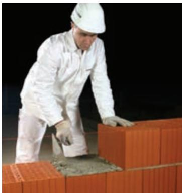
Кладочный раствор используется только в горизонтальных швах. Толщина слоя раствора должна составлять от 8 до 15 мм, оптимально 12 мм. Раствор необходимо выстилать на всю толщину стены без пропусков и пустот.
