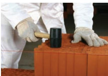
В процессе кладки стен используют шнур каменщика. Укладывающийся блок подгоняют по высоте шнура к расположению остальных блоков, используя резиновый молоток.
