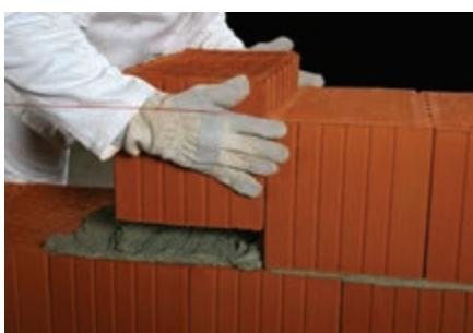
Блоки **Porotherm** в кладке соединяются между собой в пазогребневой вертикальный стык. Чтобы избежать перекосов при кладке блоки заводят сверху в пазы уложенных элементов и после этого опускают на раствор.
