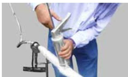
Комплект материалов для ремонта мест течей масла из под эпоксидных соединительных муфт типа СЭФ кабелей с бумажно-пропитанной изоляцией на напряжение 6/10 кВ.
