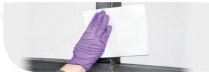
3. При обнаружении сильных загрязнений, удалить их раствором изопропилового спирта с водой в соотношении 1:1, нанесенным на чистую ветошь.
