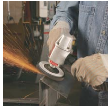
Удаление стыкового сварного шва
