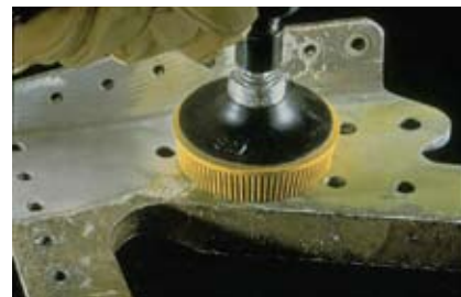
Удаление старых покрытий
