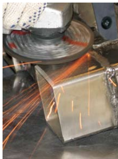
Удаление сварного шва
