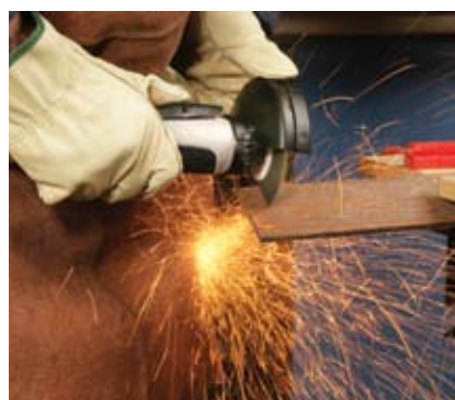
Отрезание металлического уголка
