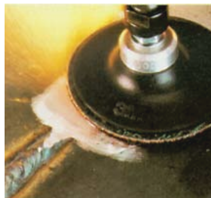
Удаление сварного шва
