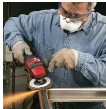
Удаление сварного шва
