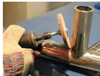
Удаление сварного шва в труднодоступных местах
