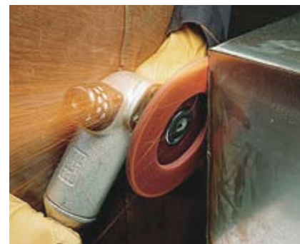
Зачистка сварного шва
