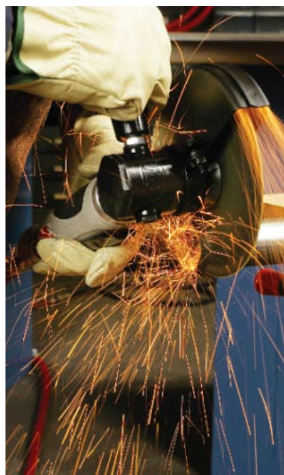
Отрезание трубы из нержавеющей стали
