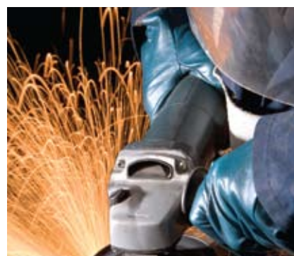
Удаление стыкового сварного шва
