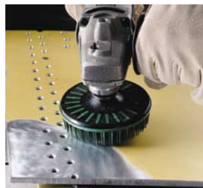
Удаление старых покрытий
