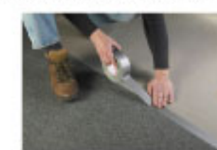
Крепление напольных покрытий, защитных полотен ткани во время строительства
