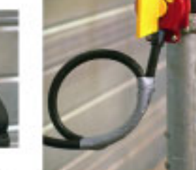
Ремонт воздуховодов, труб и прочих инженерных коммуникаций
