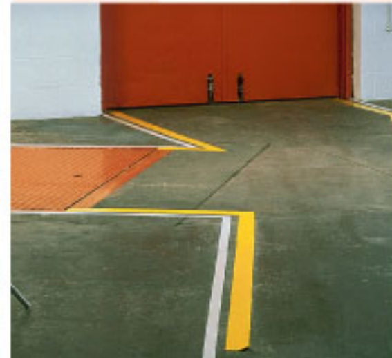
Разметка для пола производственных и складских помещений для разделения транспортных и людских потоков
