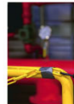
Временная фиксация при ремонте в помещениях, а также при наружных ремонтных работах
