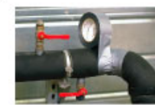
Ремонт воздуховодов, труб и прочих инженерных коммуникаций
