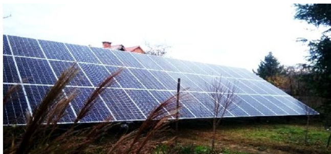
Трирядне компонування PV-панелей
