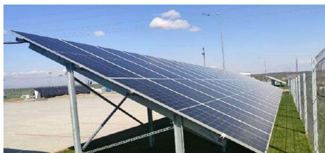
Двостійкова опорна схема
