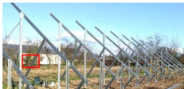
Каркас до встановлення панелей
