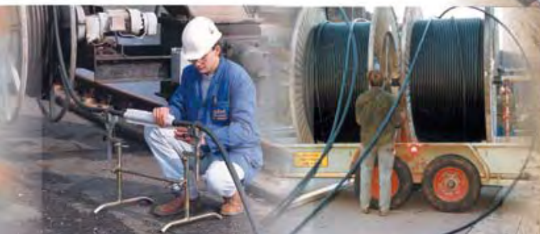
Муфта является очень гибкой, что позволяет наматывать на барабан место соединения.
