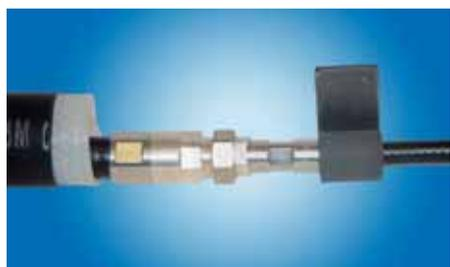
Перед соединением трубка холодной усадки размещается на кабеле. Затем полоска вспененного материала с предварительно удаленным защитным слоем, наматывается на меньший диаметр кабеля клеевым слоем вниз, как показано на фото.
