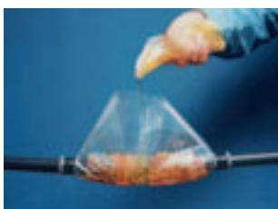
Сросток оборачивается куском специальной пленки, в конверт заливается компаунд 8882
