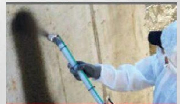
Natrysk izolacji bitumicznej
