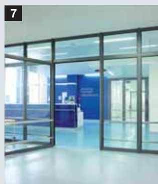
7 Трубчатые рамные конструкции
