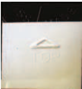
Oznaczenie „GÓRA” wskazujące poprawną pozycję wyłącznika w trakcie jego instalacji
