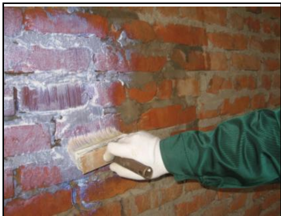
Рисунок 3.4. – Грунтование поверхности
