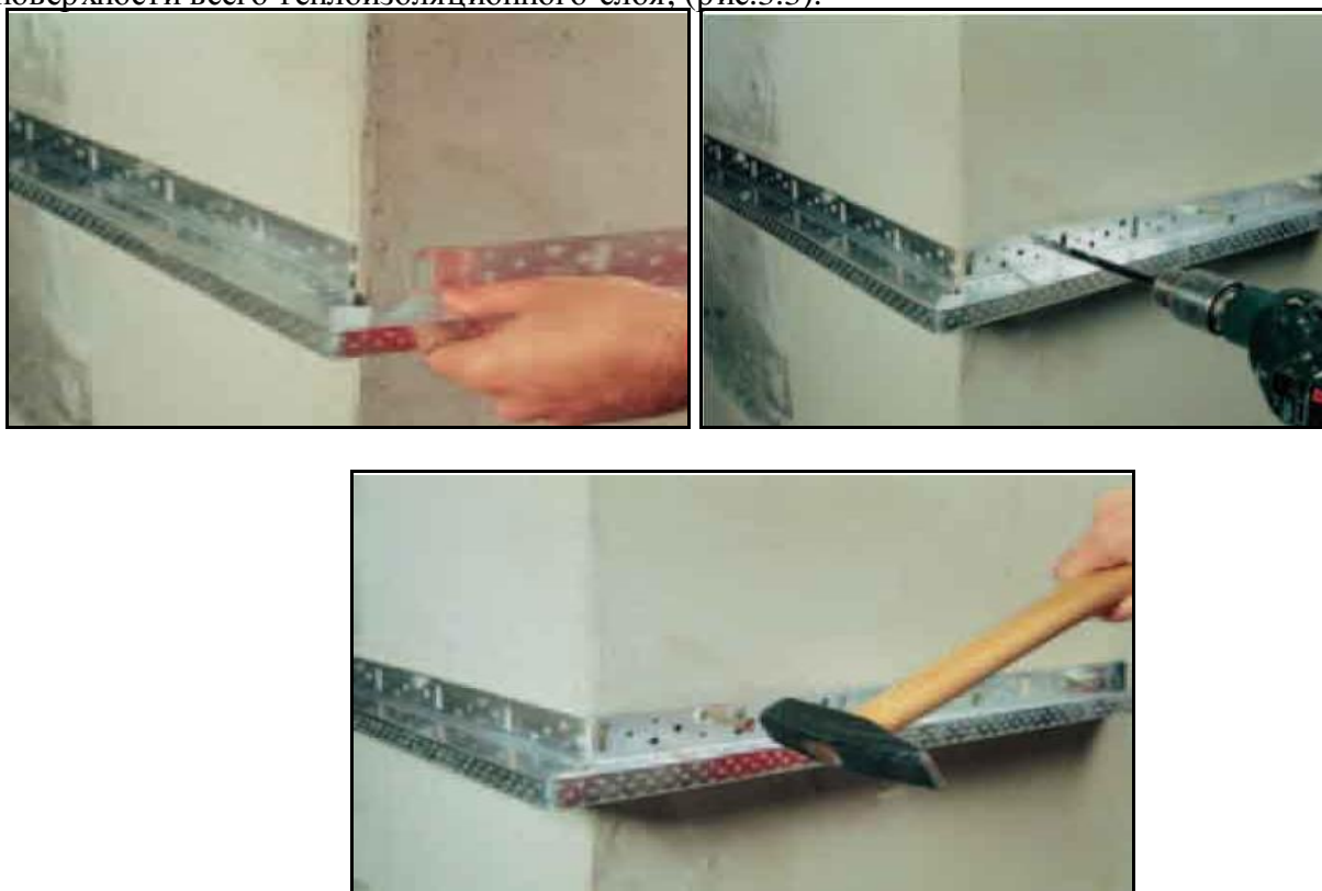
Рисунок 3.3. – Крепление цокольного профиля
