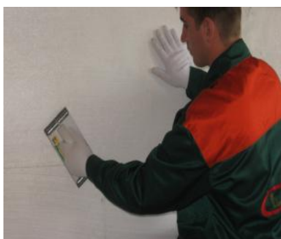
Рисунок 3.9. – Шлифование пенопласта
