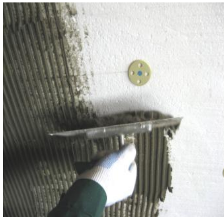
Рисунок 3.16. – Нанесение армирующего слоя
