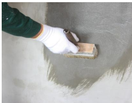
Рисунок 3.4. – Грунтование поверхности
