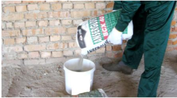
Рисунок 3.14. – Приготовление клеевой смеси ANSERGLOB BCX 40
