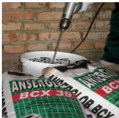
Рисунок 3.5. – Приготовление клеевой смеси ANSERGLOB BCX 39
