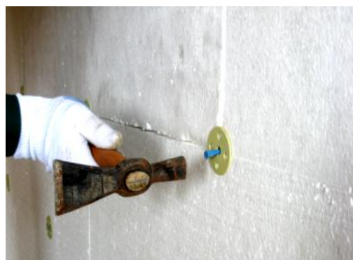
Рисунок 3.11. – Дюбелирование плит утеплителя
