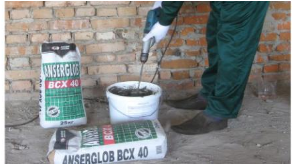
Рисунок 3.14. – Приготовление клеевой смеси ANSERGLOB BCX 40
